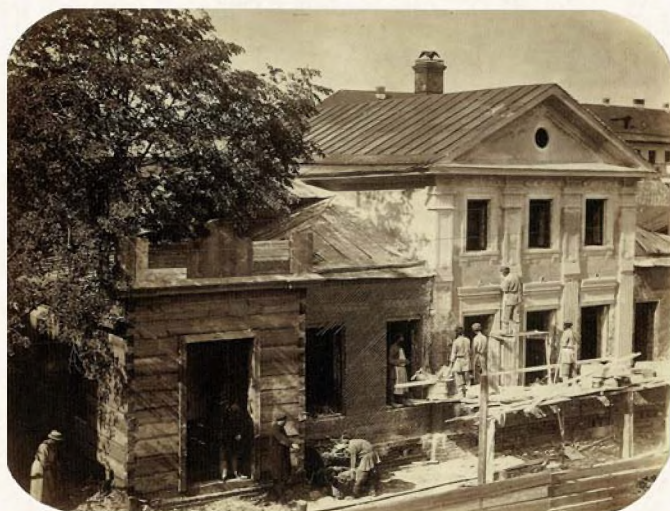
Ремонт дома в Нижнем Новгороде. Фото А. О. Карелина, начало XX века
