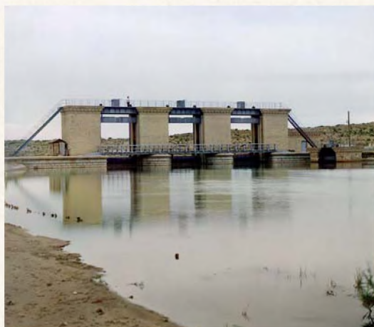
Общий вид Сунтанбентской плотины на реке Мургаб
